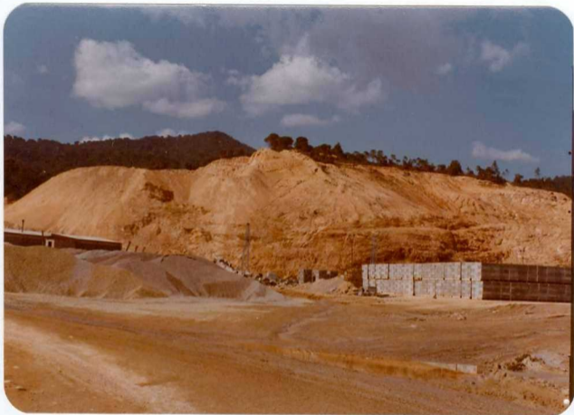
FOTO N° 328 .- Cantera y planta de prefabrica- dos en donde la materia prima es el "sauló" pro- cedente del granito situado al Sur de Santa Co- loma de Farnés. Observese el considerable espe- sor de "sauló" (15-20 m.).
