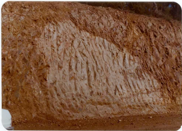
FOTO N° 314. - Contacto intrusivo en una de las zonas que han tenido que cartografiarse como = rocas metamórficas y granitoides indiferenciados. Obsérvese que el granito es ripable debido a la gran alteración que presenta.
