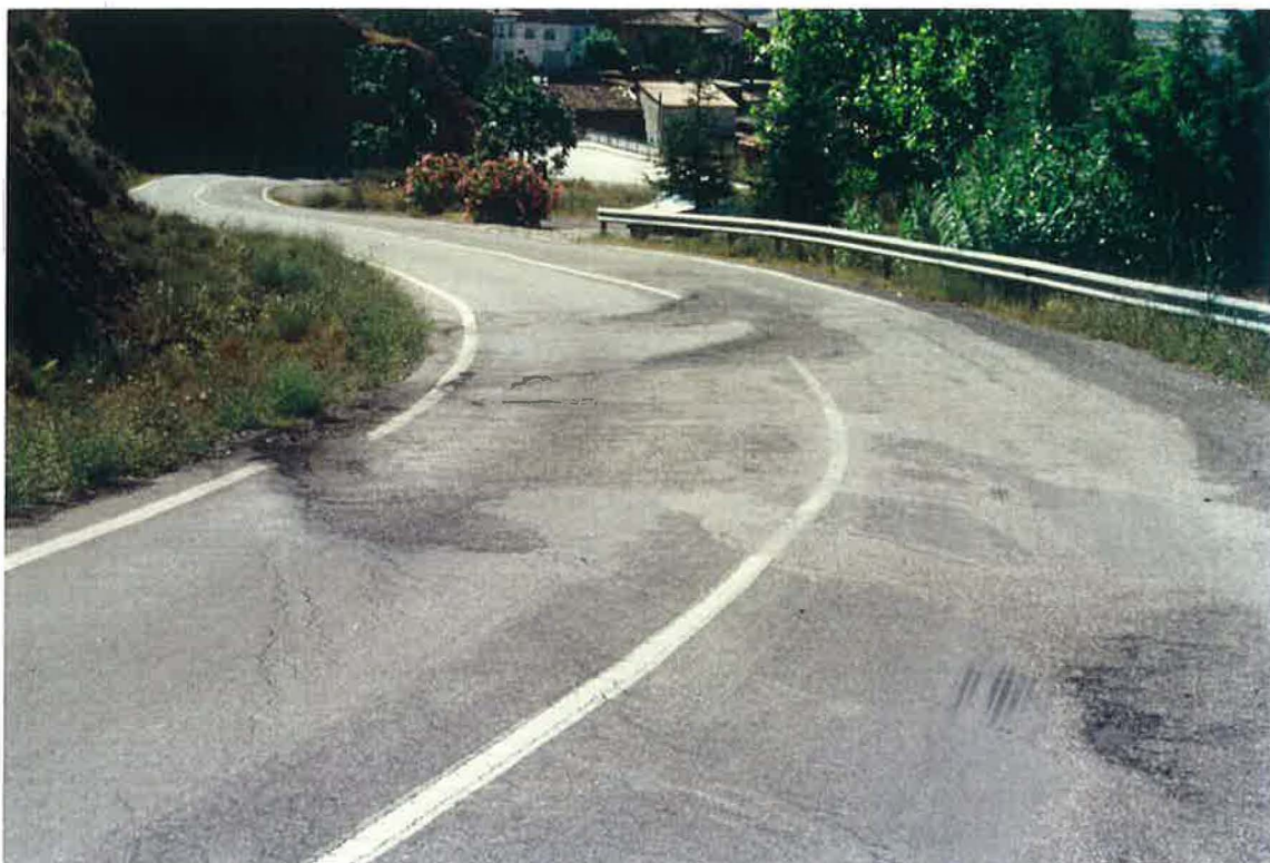
Foto 12.- Deformaciones subactuales en el firme de la carretera junto a El Grado debidas a la dinámica propia de las margas yesíferas del Triásico (diapirismo, disoluciones, etc.).
