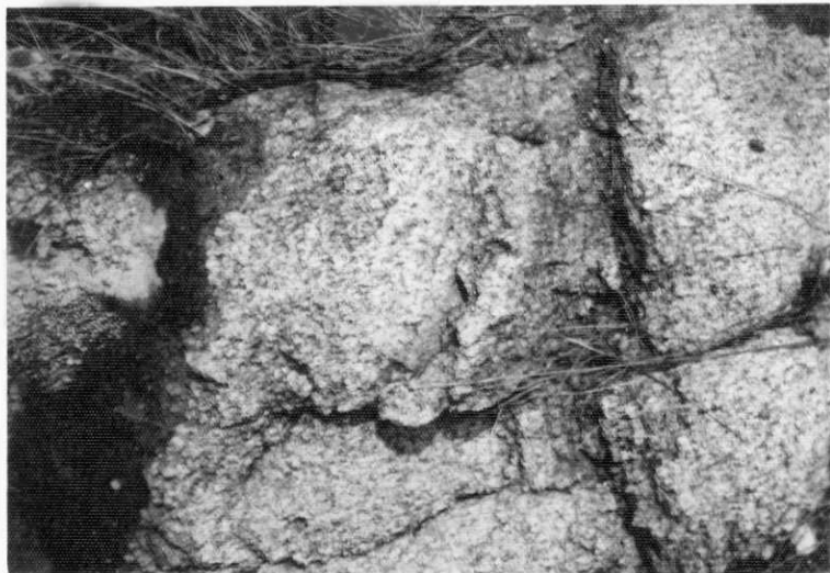
Aspecto del granito de la Rúa. Estación AH-1106
