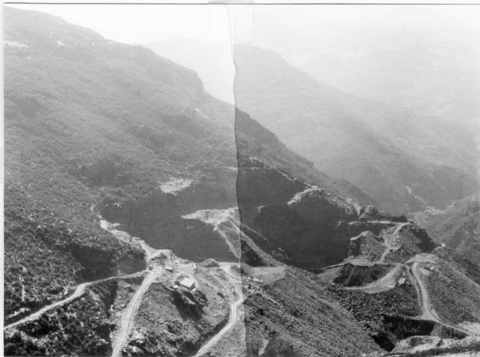
Frente de explotación de las pizarras azules (Llanvir-Llandeilo) (O_2) Penedo Rayado . Estación AH-1122
