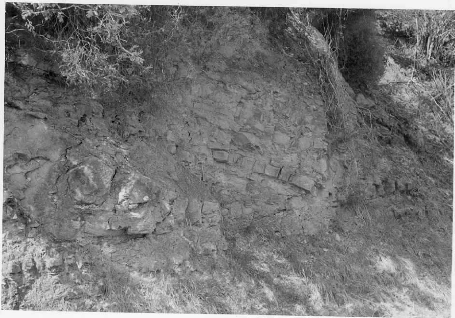
F. JP. 15 = Colapsoestructura en calizas y margas del Albiense (Fresnedo)
