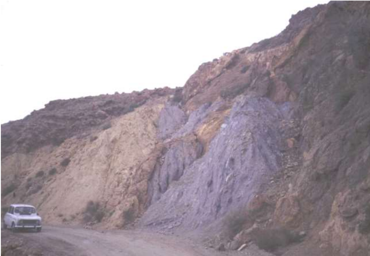
26-39-IN-FG-F 17.- Zona de Falla. Pone en contacto materiales alpujárrides triásicos y sedimentos miocenos. Borde norte de la Sierra de las Moreras.
