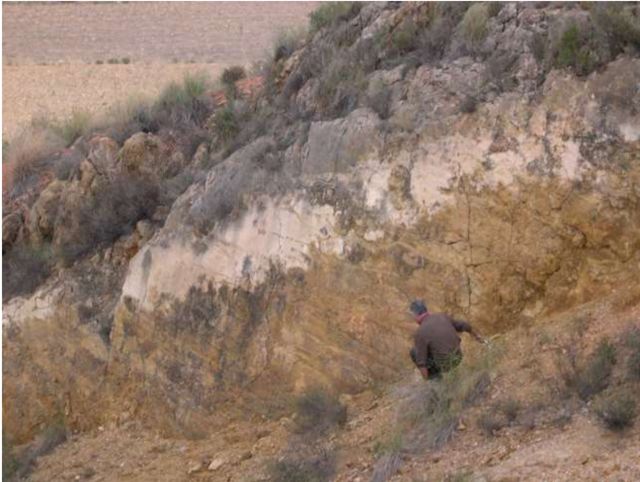
26-39-IN-FG-F 10.- Plano de falla que afecta al contacto entre los carbonatos de la Unidad del Ramonete y las filitas infrayacentes y que los llega a poner en contacto con los carbonatos de la unidad de Peñas Blancas. Sector meridional Sierra de las Moreras.
