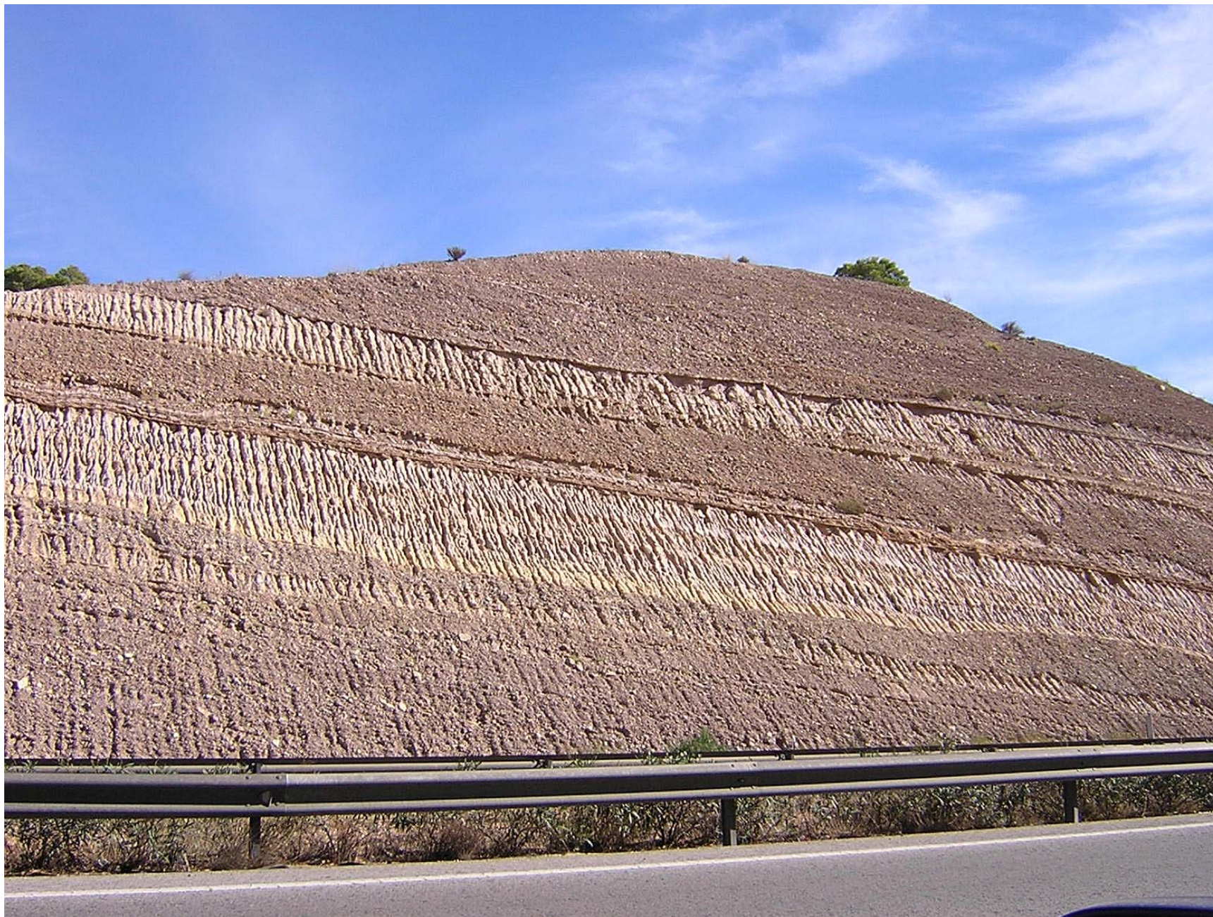
26-36-IN-FL-F 38.- Conglomerados polimíctico, arenas y lutitas rojo-violáceos (39) en los taludes de la A-92. Entrada al viaducto sobre el Río Segura
