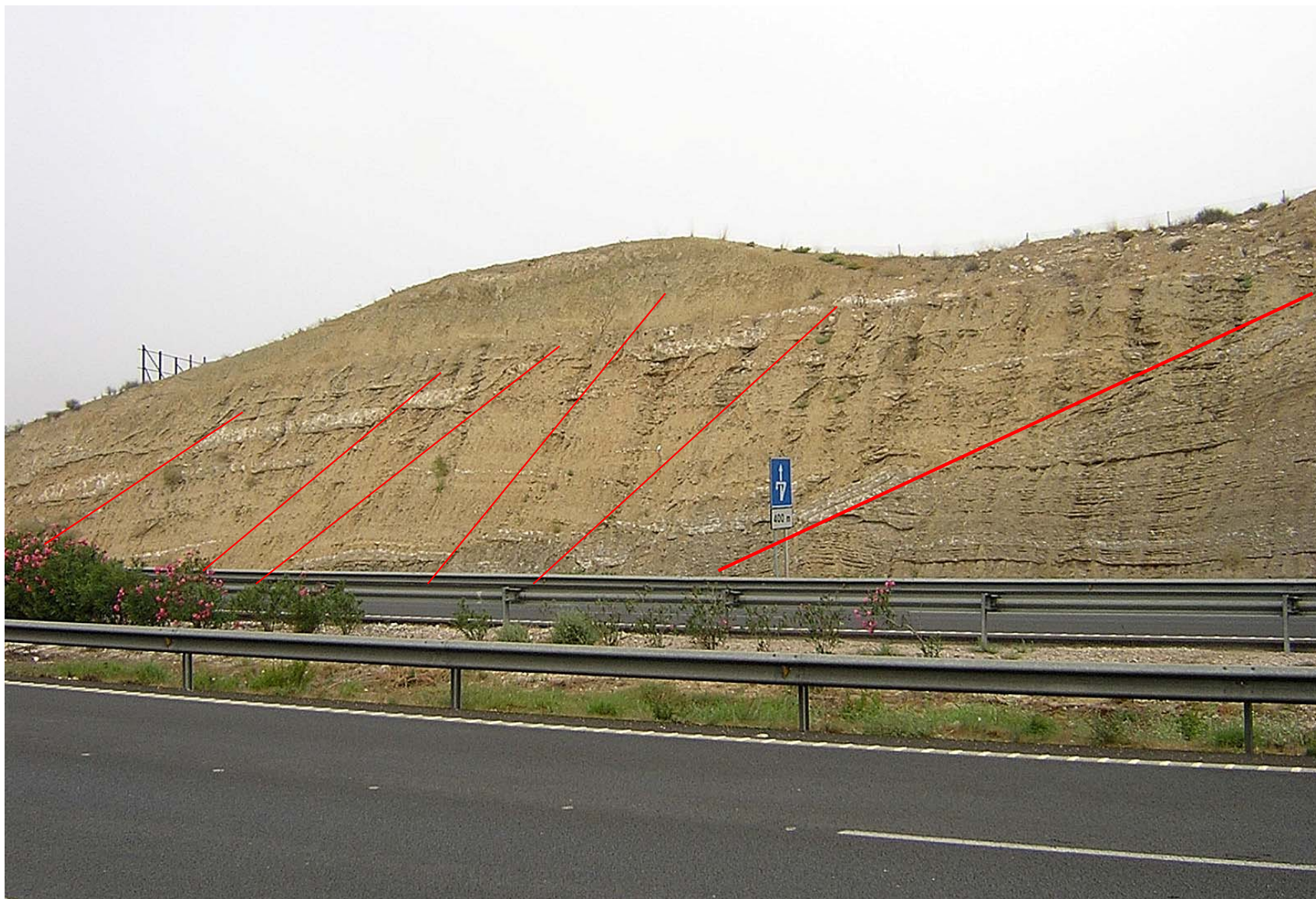
26-36-IN-FL-F 19.- La extensión Messiniense. Yesos en láminas y nodulares. Talud de la Autovia a la altura de Molina del Segura
