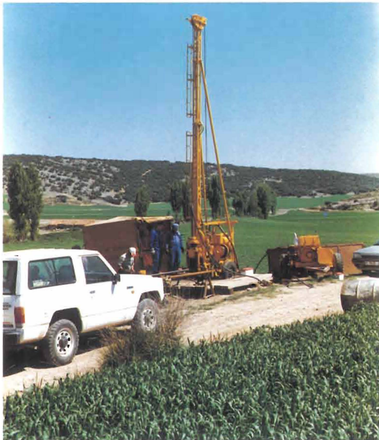
Figura 20. Sondeo de reconocimiento en Añavieja. (Proyecto Hidrogeológico de Soria SGOP-DGOM) (Foto E.S.)
