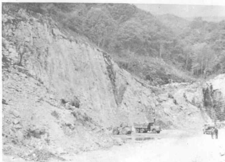
Foto 5.— Frente de explotación en una de las canteras de Sierra Aloúr.
