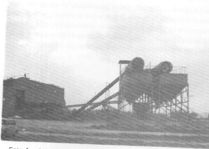
Foto 4.— Instalación de tratamiento de las gravas procedentes de la explotación 81.
