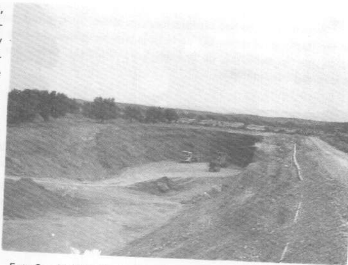
Foto 3.— Explotación de gravas aluviales en Rambla Castellana (81)
