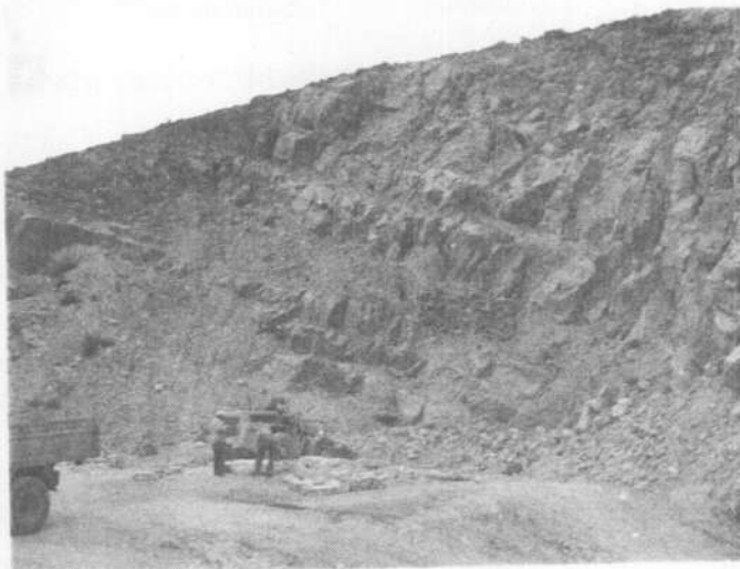
Foto 6.— Cantera 77 (Liria). Se extraen áridos y piedras para construcción
