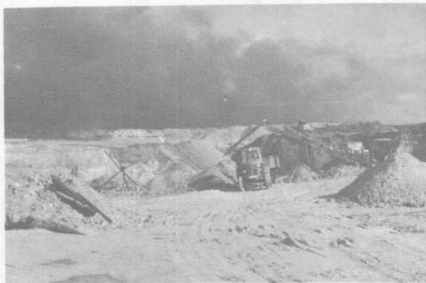
Foto 2.- Frente de explotación de zahorra e instalaciones de clasificación en Villamayor de Santiago. Cantera 362.
