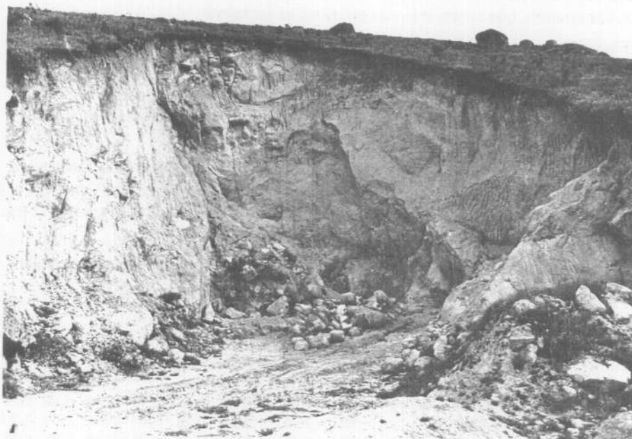
Foto 4.— Explotación de jabre granítico como material de préstamo, cerca de Cabrero (E-68).
