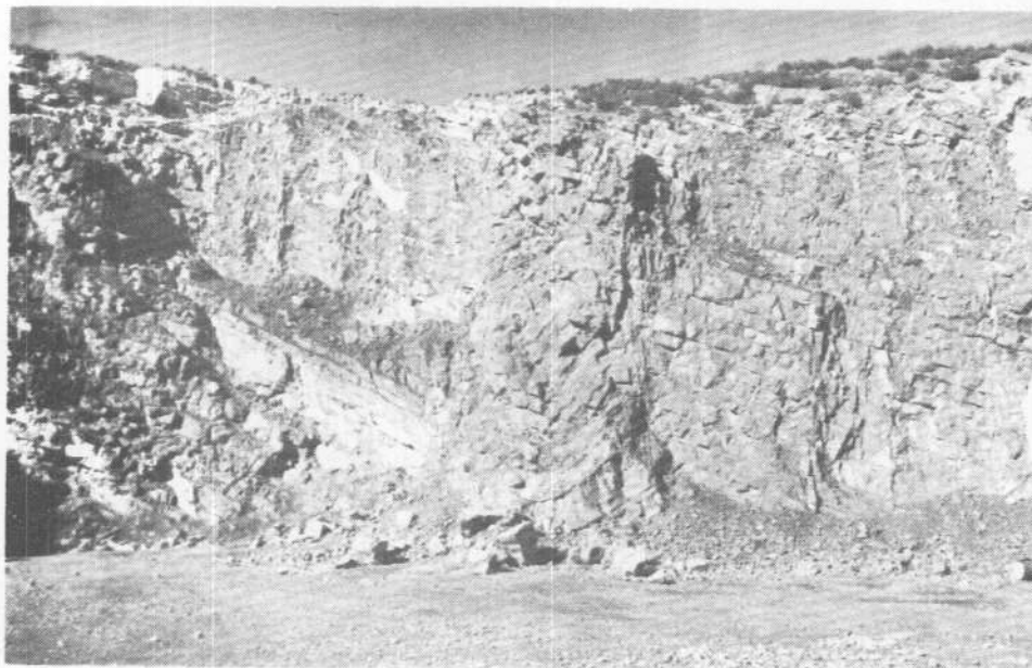
Foto 12.— Frente muy tectonado de la cantera núm. 13 (Ricla) en caliza jurásica
