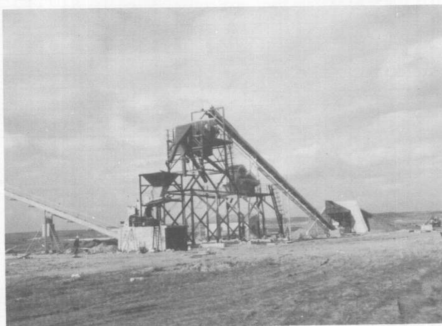
Foto 9.— Detalle de una planta de clasificación y machaqueo en Coreses.
