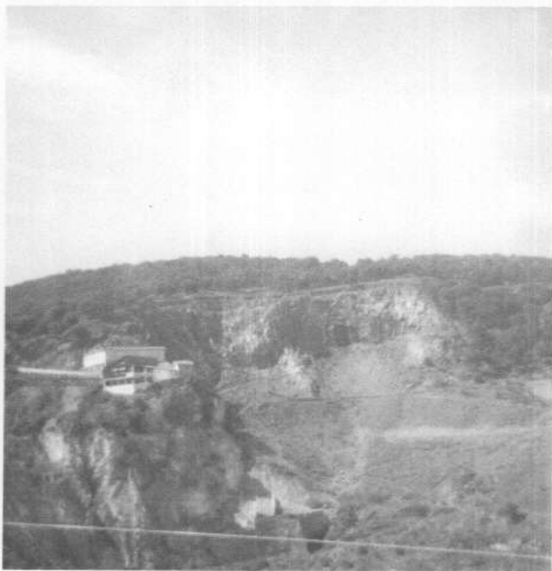
Foto 4.— Explotación abandonada de caliza jurásica, situada en Ortigosa en Cameros (Logroño).
