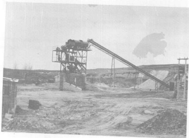
Foto 6.— Planta de clasificación y trituración de arenas correspondiente a la explotación de la estación 245, (Villagonzalo—Pedernales)
