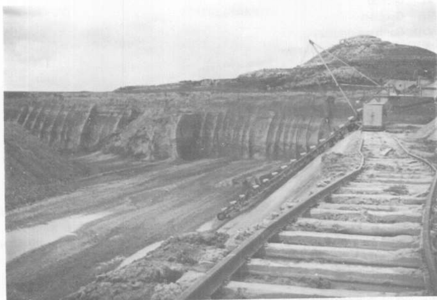
Foto 7.— Sistema de ripado en la explotación de cangilones
