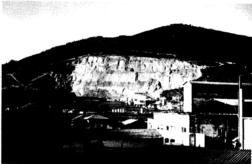
Foto 5.— Explotación de calizas para cemento en Zarátamo (Vizcaya)
