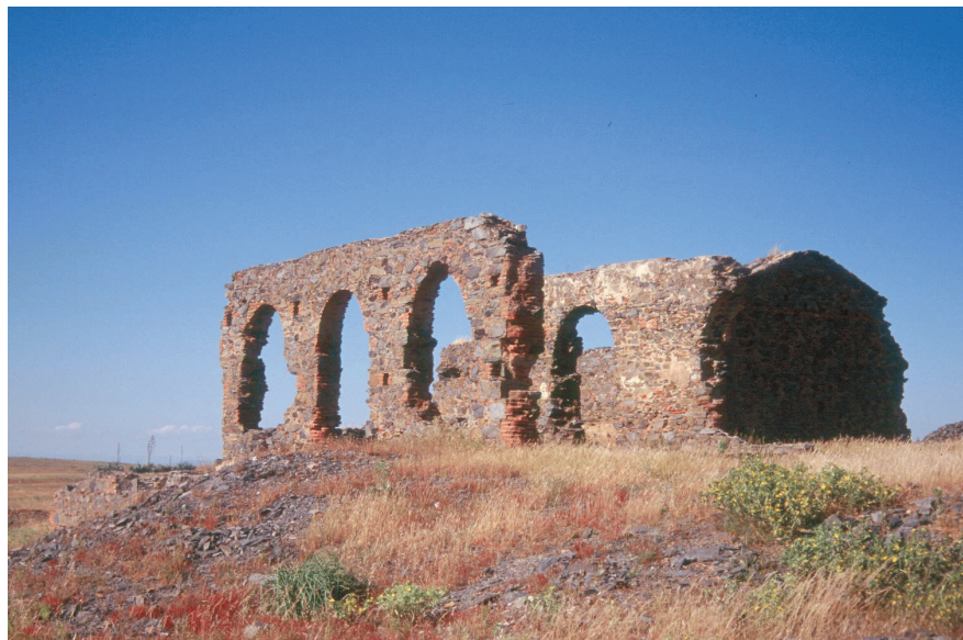
Foto 3.1. Ruinas de la mina El Peñoncillo (Castuera)
