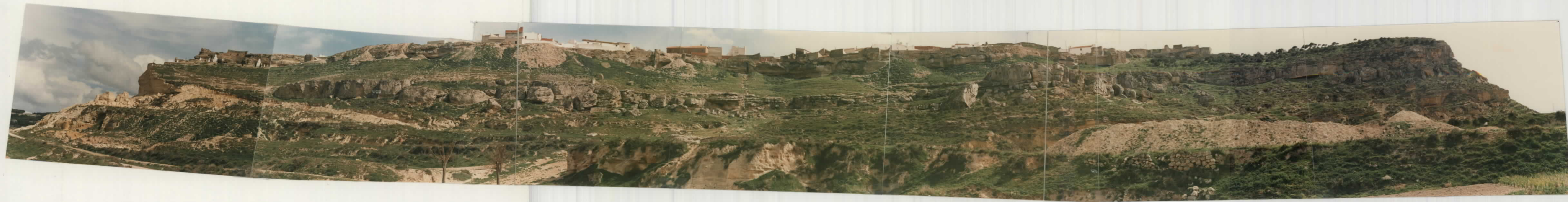
Foto nº 55.- Panorámica del desplome reciente, que se prolonga hacia el Norte.
