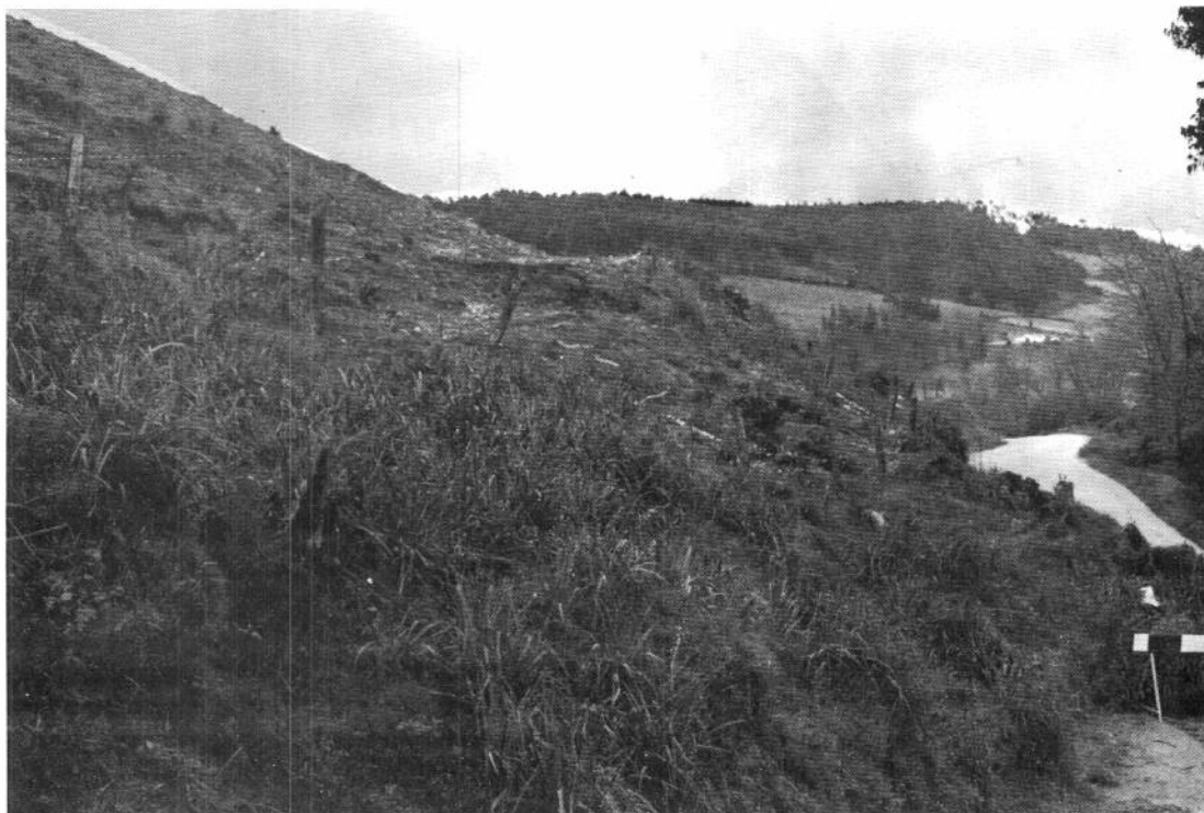
Fotografía núm. 5.— Deslizamiento, en la carretera de Fontaciera, de materiales coluviales sobre J_1 .
