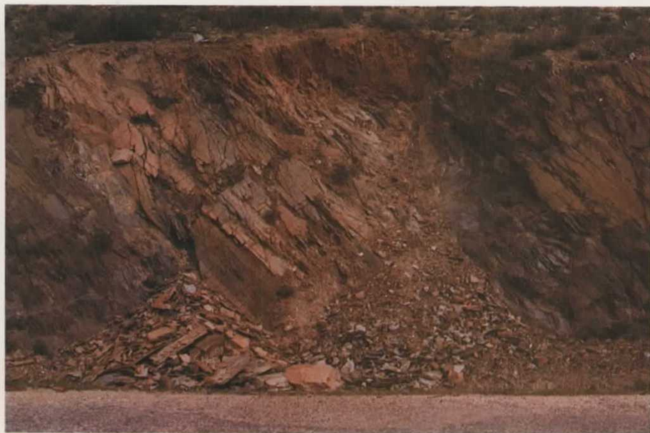
Pequeño deslizamiento por tectonización en un talud de la carretera Tahal-Macael, cerca de Benitorafe.
