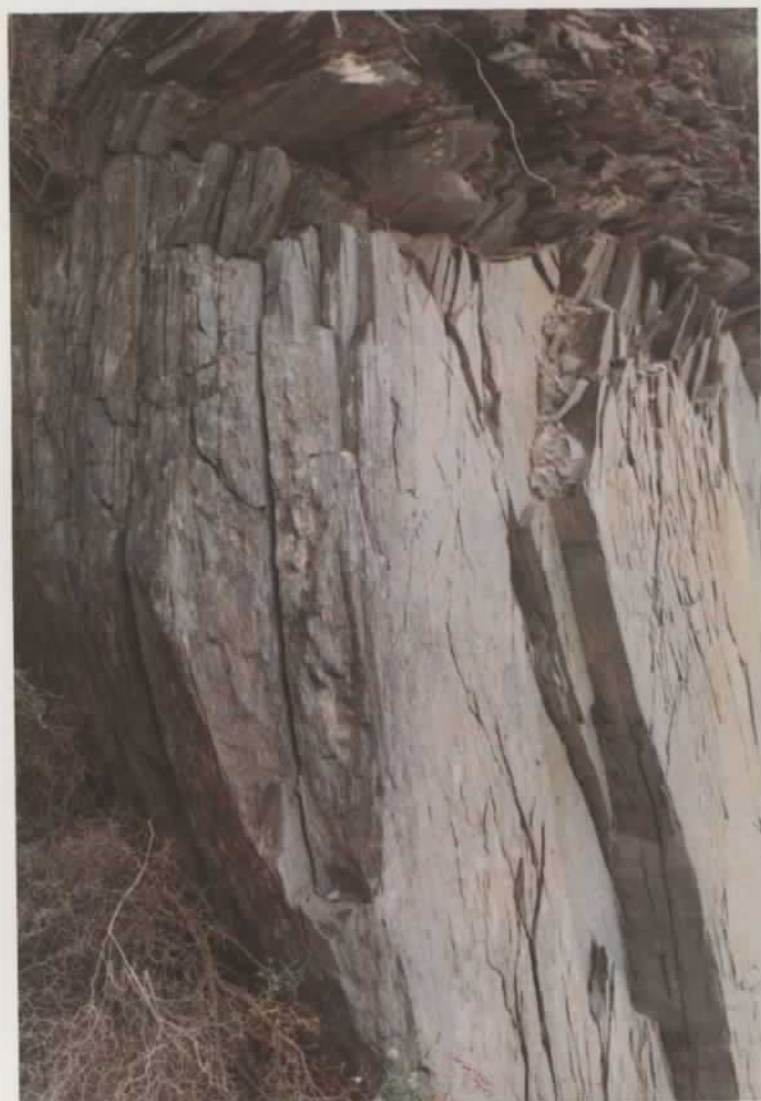
Vuelco de talud en filitas. Carretera Cuevas de Almanzora- Aguilas
