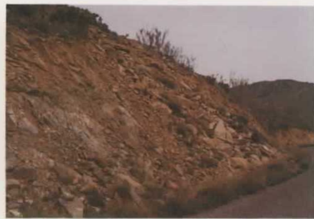
Deslizamiento por tectonización en un talud de la carretera a Tahal.
