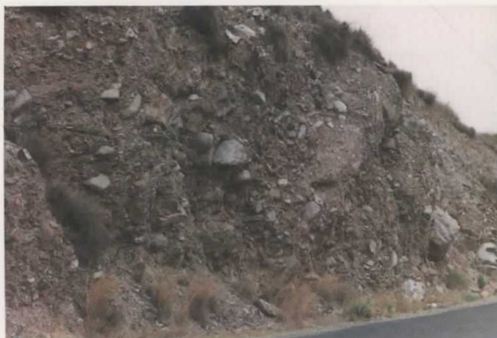
Brecha en la carretera de Cantoria a Albánchez.
