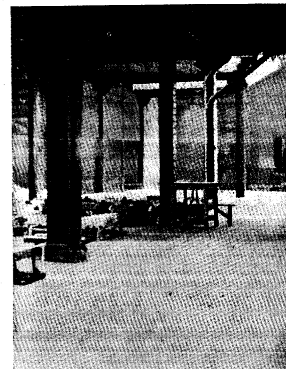
Fig. 1.—Enlosado de fundido Lafarge sometido a una temperatura de 700° y a la circulación de carretillas pesadas. (Fábrica de Clichy de Ét. Chaboche—La Salamandre—en París.
