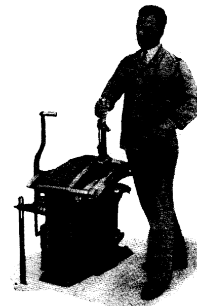
Fig. 30.—Caballete de maniobra de palanca única B.B.C.
