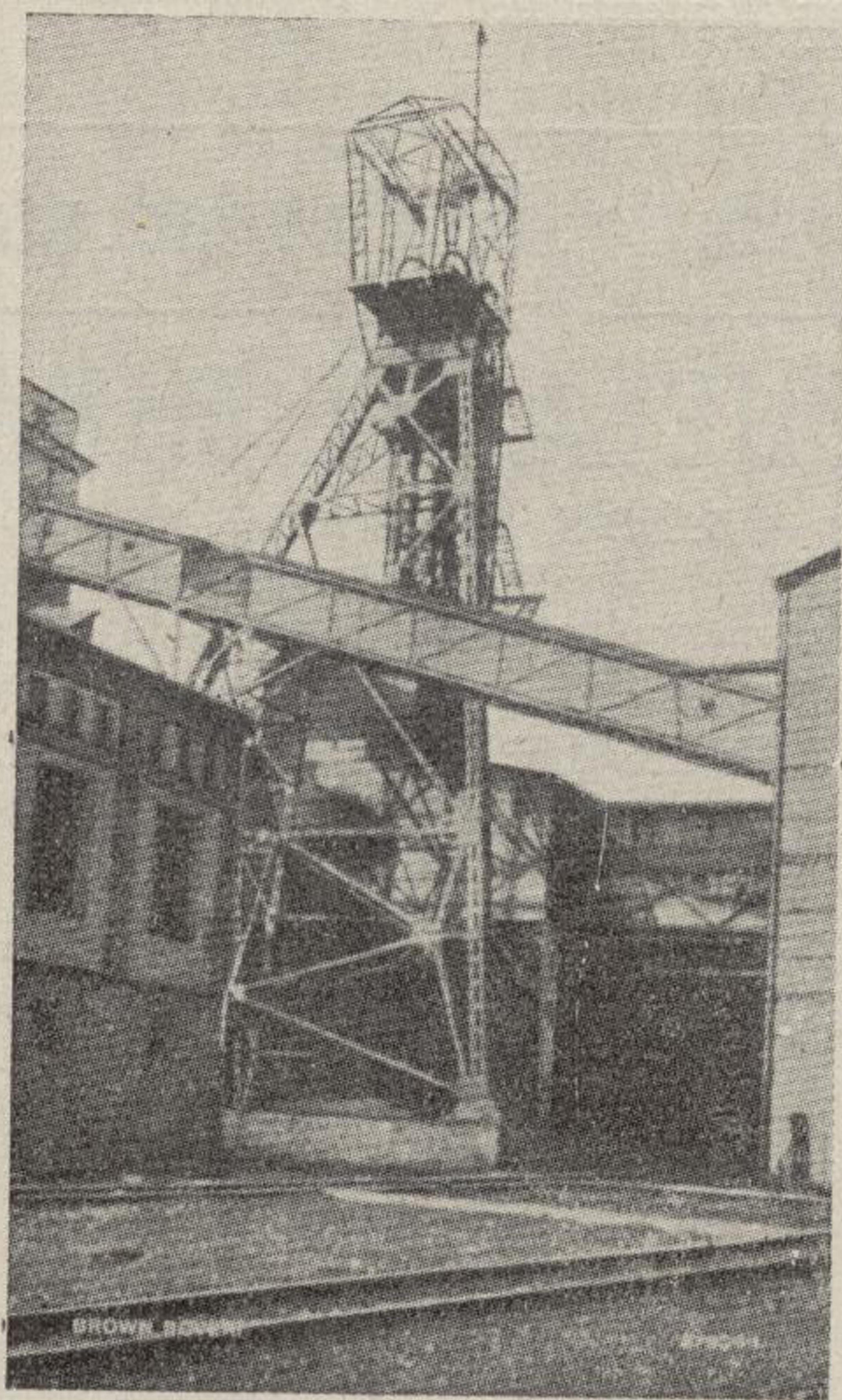
Fig. 26.—Castillete de la instalación de extracción por "skips" Ostfeld.
