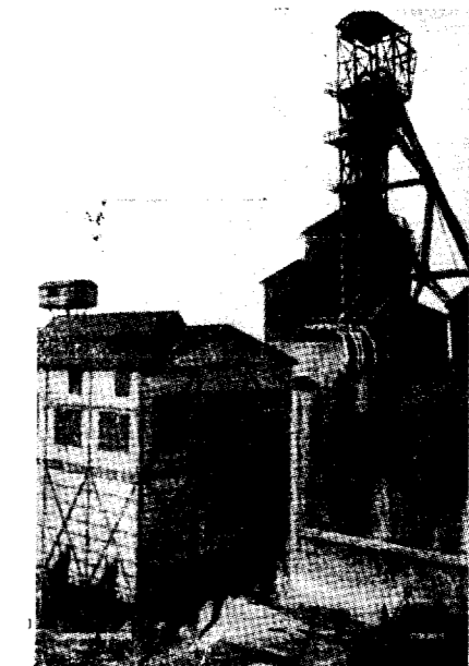
Fig. 31.—Instalación de extracción por «skips» de Grodziec.
