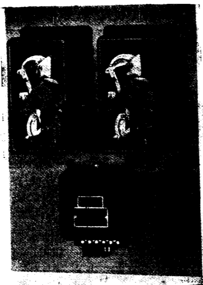
Fig. 56.—Relés selectivos para redes de cables.
