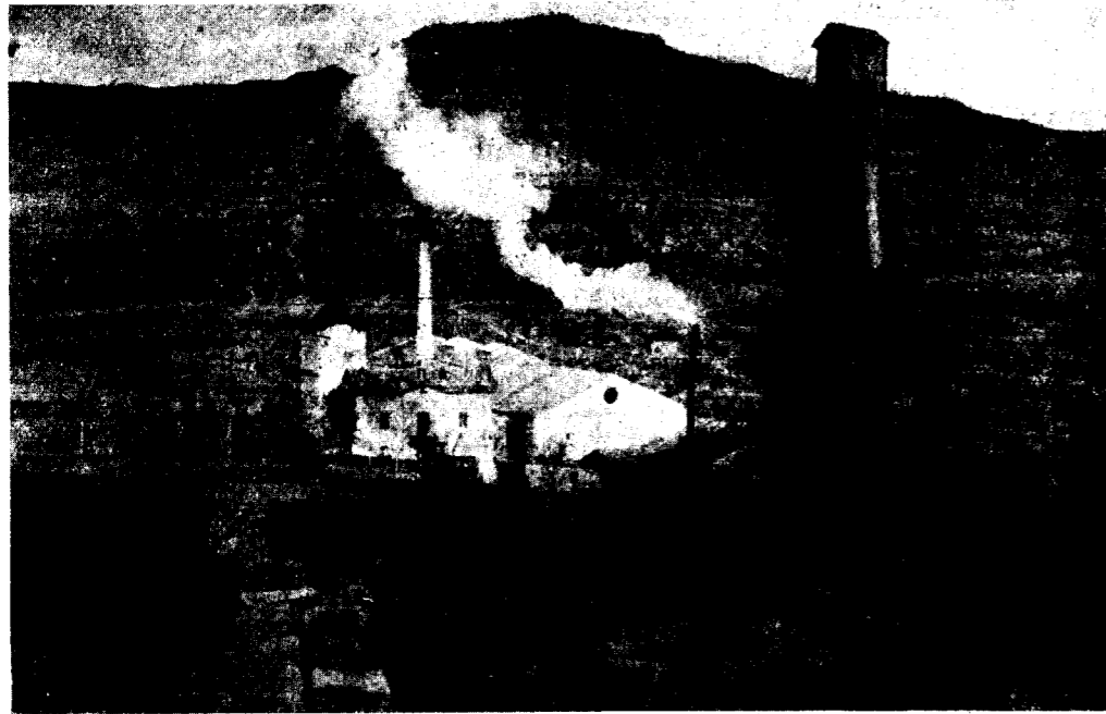
Puig-Reig (Barcelona). Sondeo por rotación para sales potásicas. Profundidad, 700 metros.
