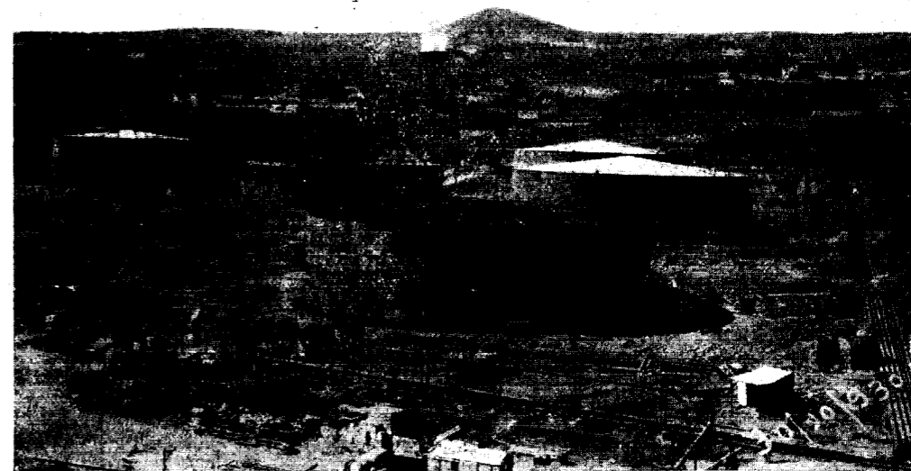
Santa Cruz de Tenerife (España). Depósitos para 8.000 toneladas de petróleo cada uno, de la refinería de la Compañía Española de Petróleos.
