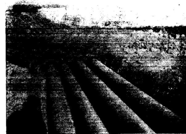
Santa Cruz de Tenerife (España) Pipes lines para llevar el petróleo bruto a la refinería de la Compañía Española de Petróleos.
