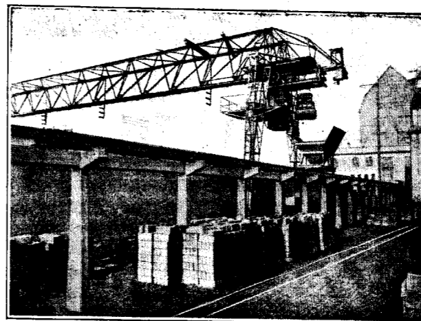
Transportador Redler para conducción de sales a las naves de tratamiento.
