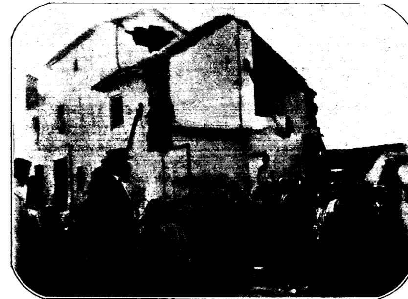
Montilla.—Calle Malgar. Hundimientos originados en el acto del sismo, desplome general; movimiento vertical dominante.
