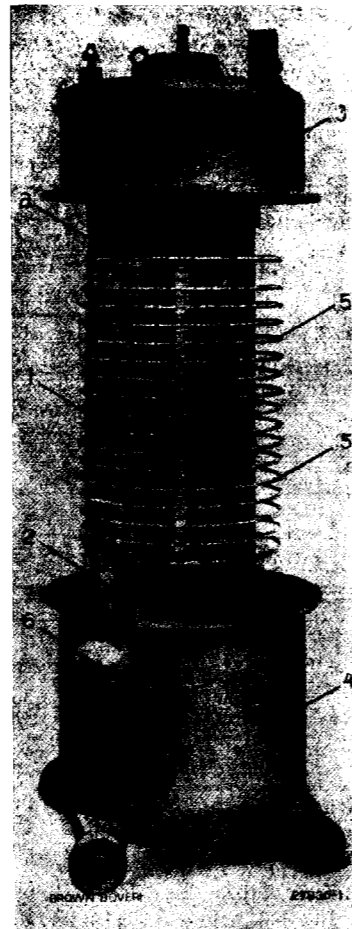
Fig. 17.—Transformador de tensión del tipo «aislado» para 150 kilovatios.
