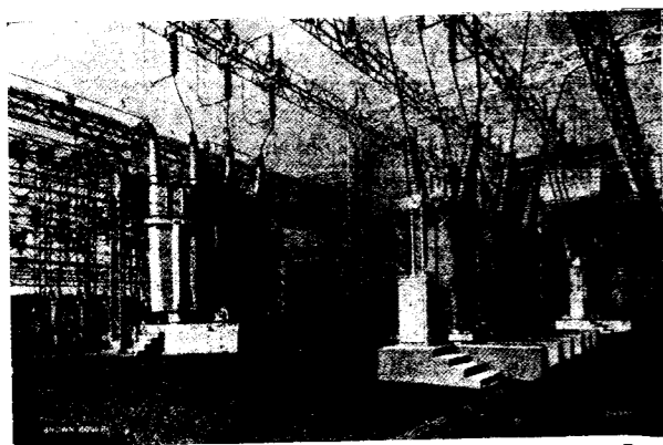
Fig. 34.—Subestación al aire libre de Cislago en Turín. Grupo de interruptores y de transformadores a 150 kilovatios.
