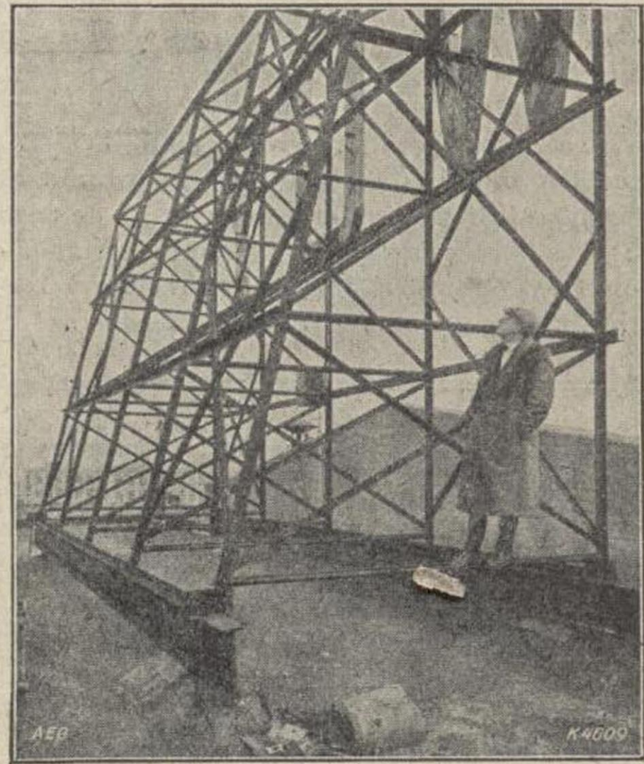
Fig. 13. — Entramado de hierro soldado por arco voltaico.
