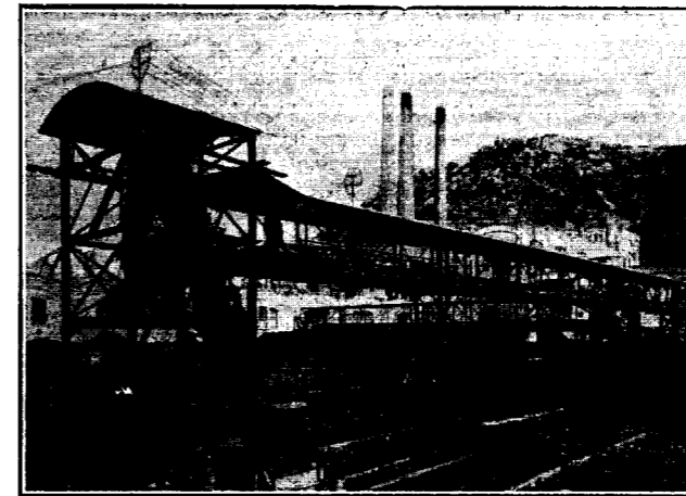
Fig. 5.a - Conjunto de la instalación.
