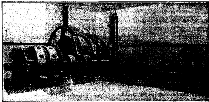
INSTALACIÓN EN EL POZO ST. PIERRE DE LAS MINAS DE OZELADZ, EN SOSNOWICE (POLONIA RUSA).—Motor trifásico de doble colector, potencia máxima 280 HP., 230 v. p. m., 500 voltios (50 periodos). Carga útil 1.400 Kgs., profundidad 220 m.
