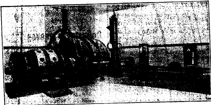
INSTALACIÓN EN EL POZO ST. PIERRE DE LAS MINAS DE CZELADZ, EN SOSNOWICE (POLONIA RUSA).—Motor trifásico de doble colector, potencia máxima 280 HP., 230 v. p. m., 500 voltios (50 periodos). Carga útil 1.400 Kgs., profundidad 220 m.
