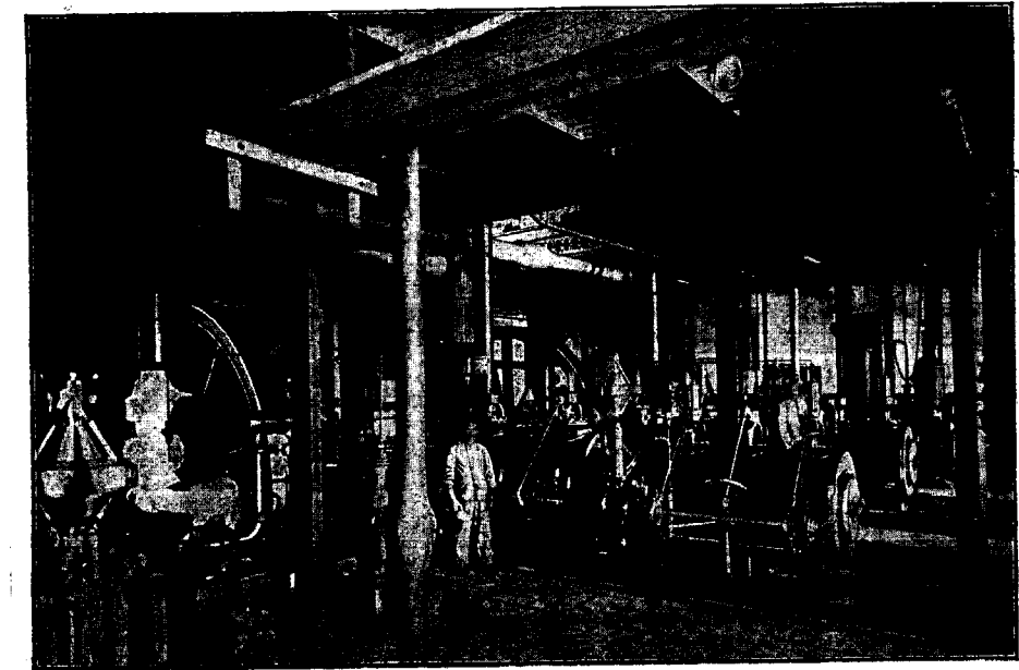
Fig. 2. a —Sala de máquinas de La Negra , en Buenos Aires.
