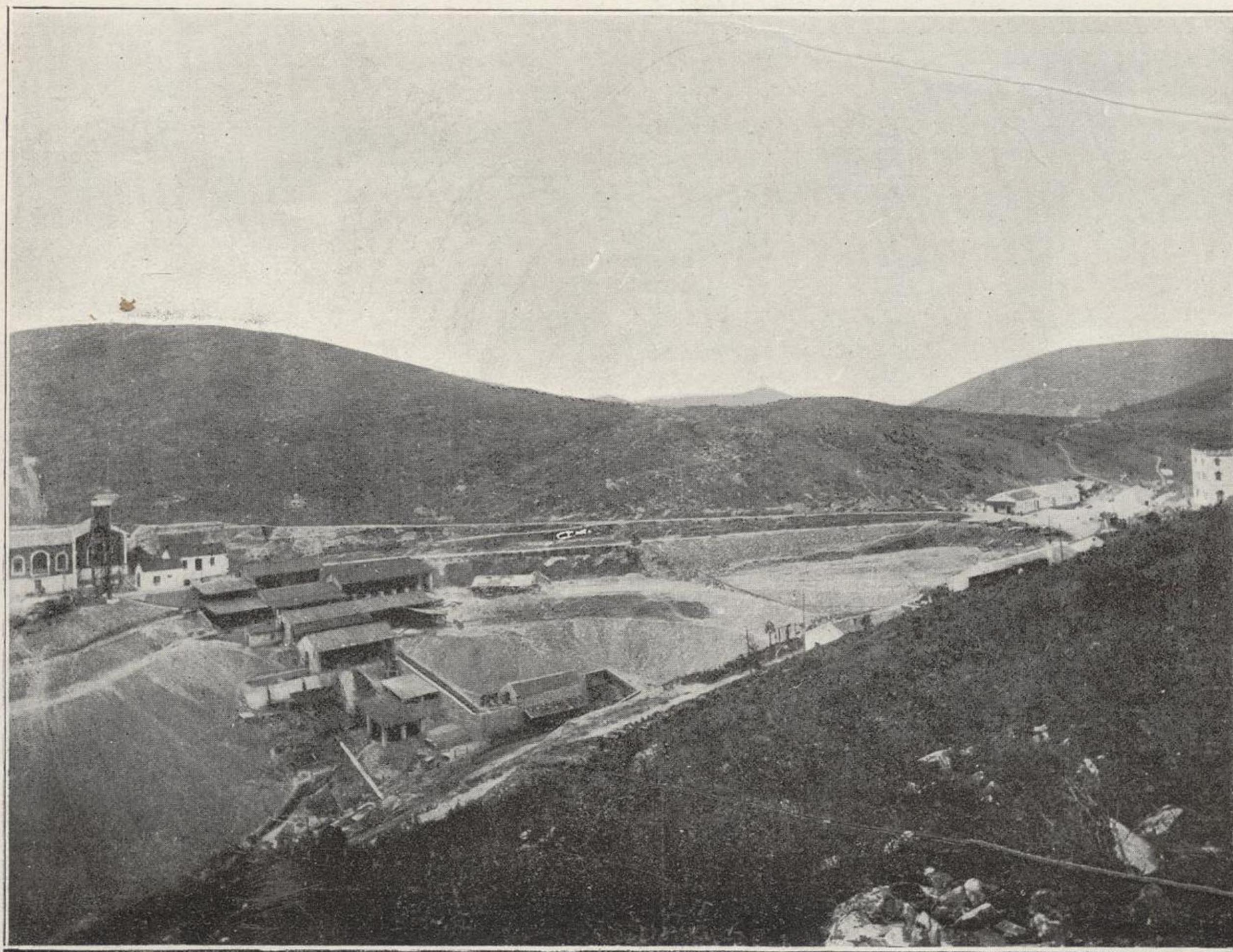
Figura 1. a .—Vista general de las instalaciones de la Sociedad minera «El Guindo»
