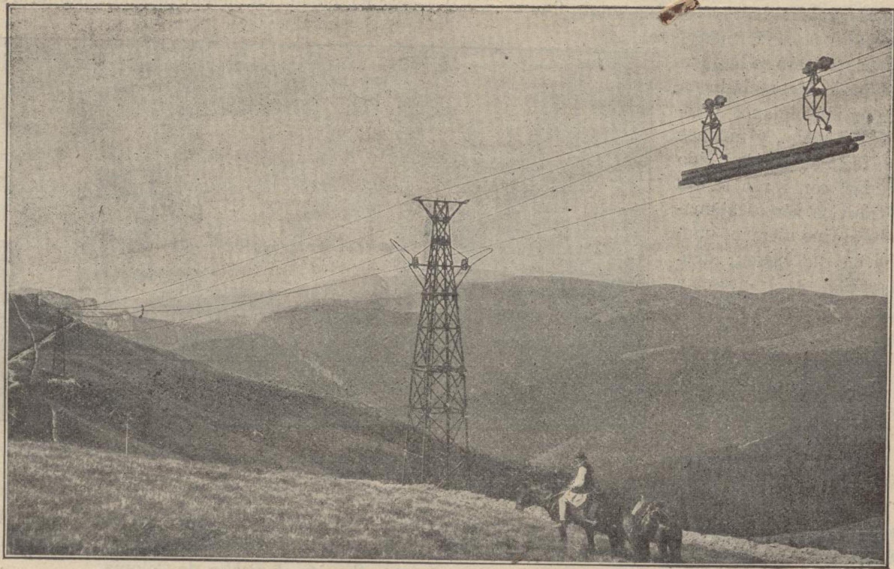
FIG. 4. a .—Tranvia aéreo de Bustemi (Rumania), para el transporte de troncos de árboles.
