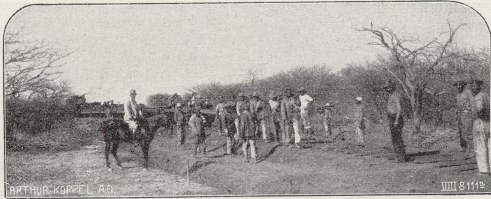
Fig. 3. — COLUMNA DE TENDIDO DE VÍA, DURANTE EL TRABAJO
