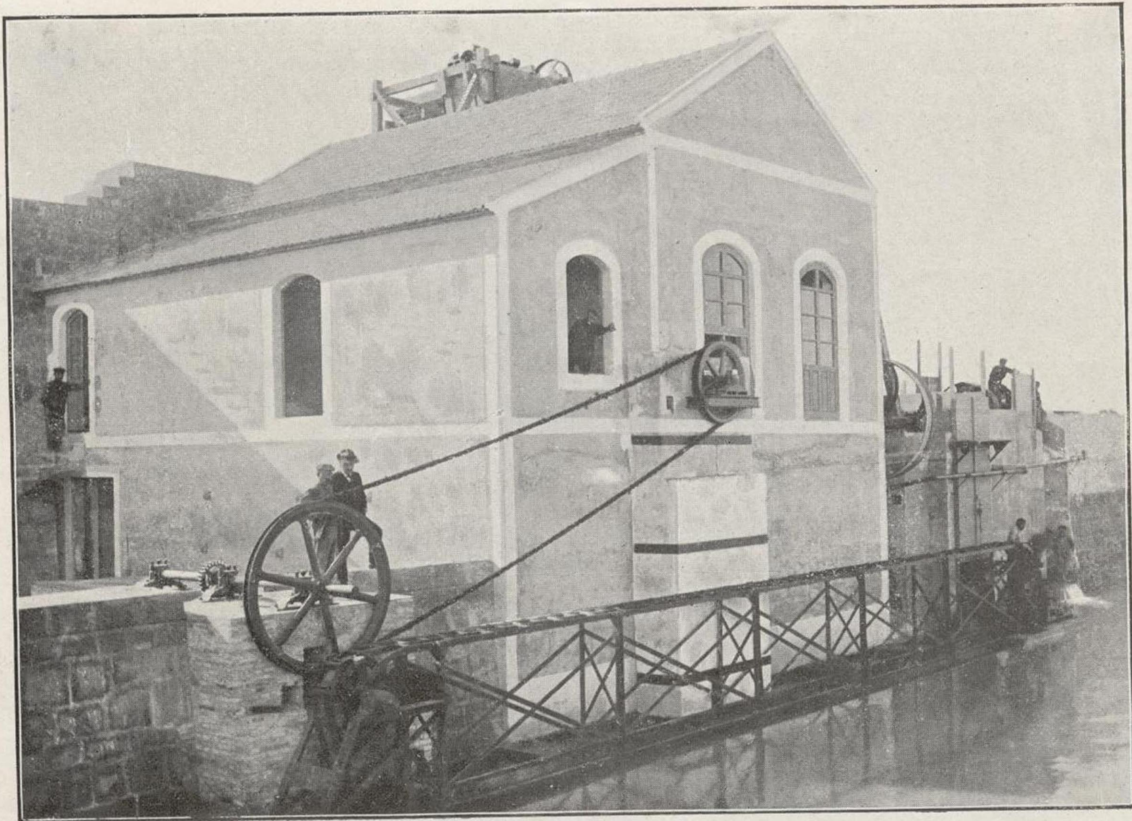
Figura 4. a .—Transportador mecánico de sal roja para convertirla en blanca.
