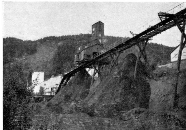
Foto 7. - Planta de concentración y depósitos de concentrados de la mina Fosdalen.
