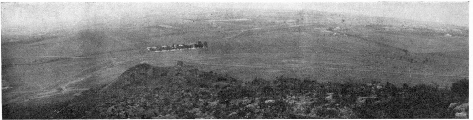
Foto 10.—Panorámica de la rambla desde el Sur de la carretera de Albuñón a Cabo de Palos, hasta el mar.
