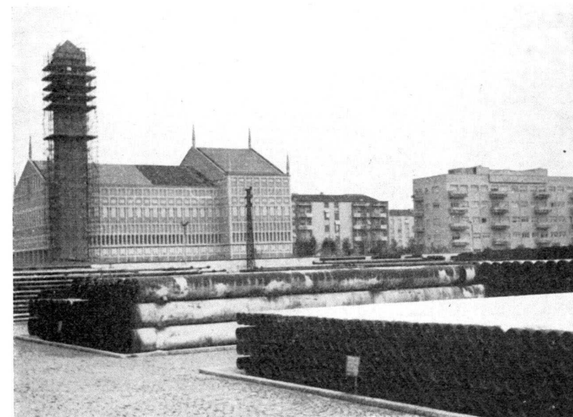
Fotg. 2.—San Donato Milanese.—Parque de tubería y panorámica del barrio residencial; destaca la moderna arquitectura de la iglesia todavía en construcción. (F. Muñoz.)
