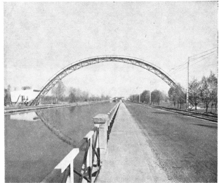
Fotg. 12.—Metanoducto de 42 cms. Cremona-Busfo, Arsizio. Puente sobre el canal en Trezamo (flecha, 16,5 metros; longitud, 55 metros).
