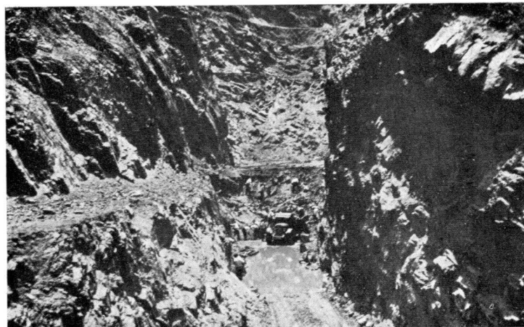
Fot. 7.—Rebaje de San Guillermo.
