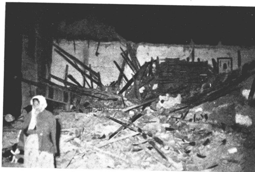
Casa derrumbada en Atarfe, en donde resultó un muerto y dos heridos graves.
