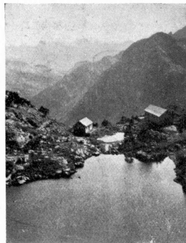
Lagos de Arriel y toma de aguas en construcción para el salto de Resposmuso. Granitos y digestión de calizas.
