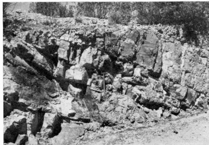
Fot. 1.—Cuarcitas y pizarras arenosas del Cámbrico en la trinchera de la carretera de Robledillo a Robledo del Mazo, junto a aquella localidad. Materiales muy diaclasados.
