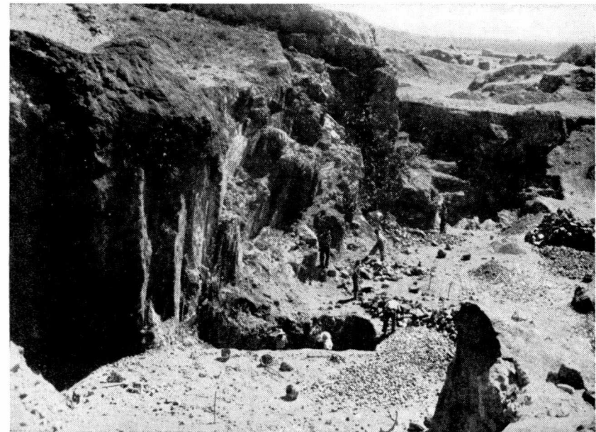
Fig. 2.—Explotación en cantera de los materiales gneisicos, por metamorfismo regional del pizarral cambriano potsdamiense en el paraje de San Blas, inmediato y al Oeste de Almendralejo, Badajoz. Se aprecia bien los diferentes planos de las diaclasas que favorecen mucho la explotación de la cantera.
