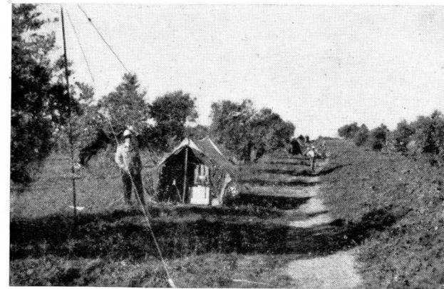
Foto 6.—Equipos receptores dispuestos para registrar el sismo artificial
