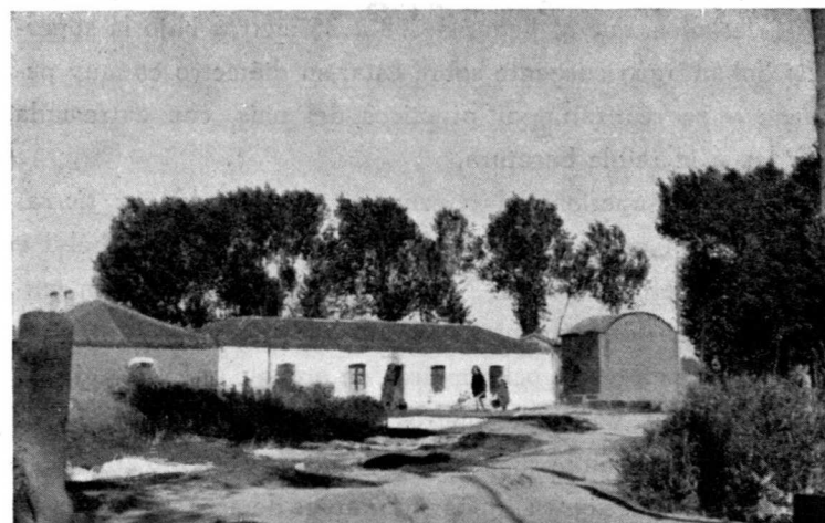
Foto 3.—Nava de Arévalo.—Pozo artesiano del Ayuntamiento.
