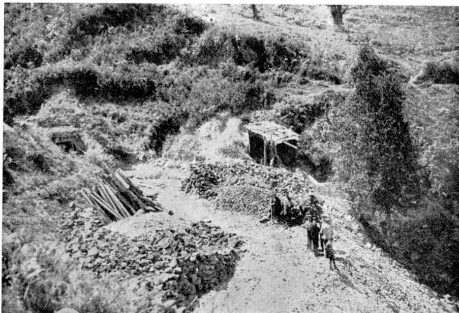
Figura 2.—Monte de Bodes. Entrada del transversal, donde se llevan a cabo las labores para el reconocimiento del paquete de margas bituminosas. Por encima de la boca de la mina, y al pie del sombrero, aparecen los contactos con las arenas albienses.
