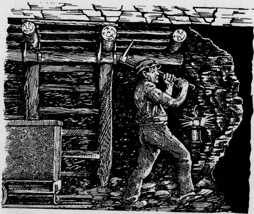
Fig. 135.—Embrochalado de protección sobre prolongas colgadas.
