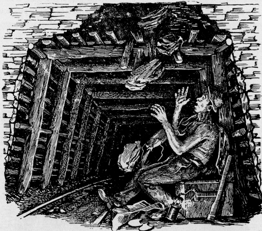
Fig. 137.—Grave consecuencia de un desprendimiento en una campana.
