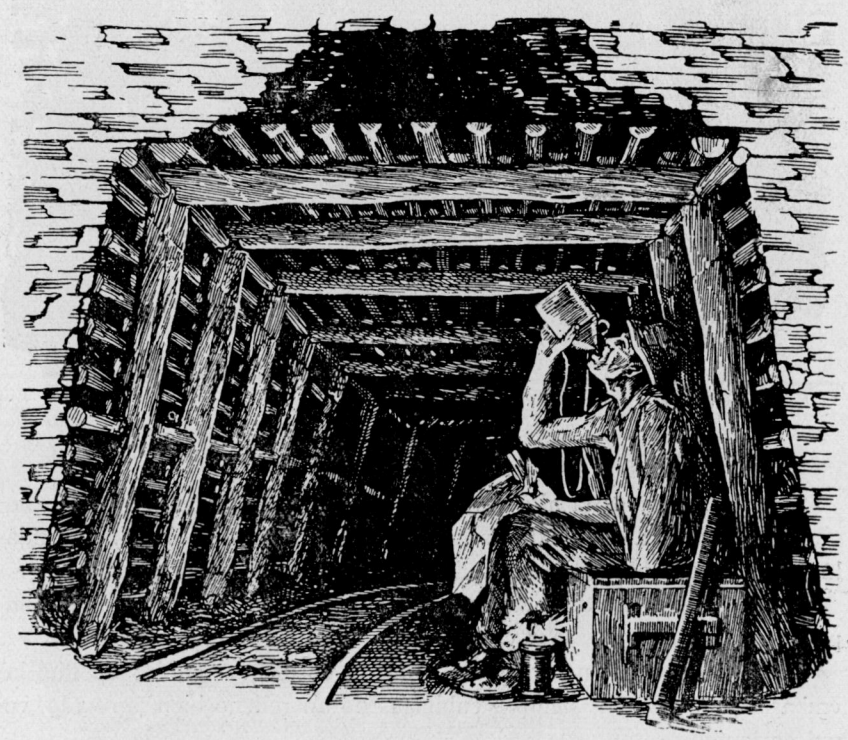
Fig. 136.--Los huecos en campana son muy peligrosos.
