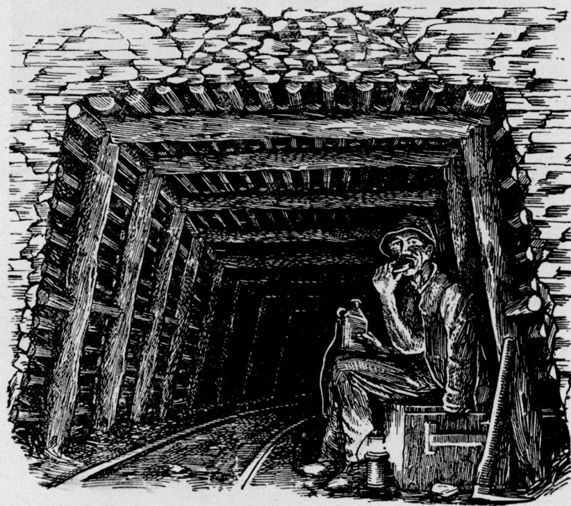
Fig. 139.—Una campana bien rellena ofrece una gran seguridad.
