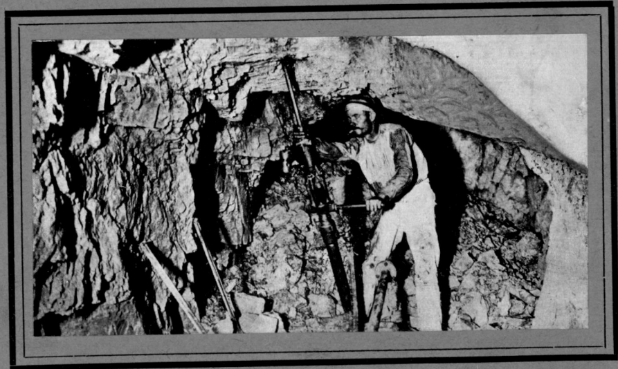
Trabajo en realce con perforadora. Los Guindos. (Foto. del Instituto Geológico.)
