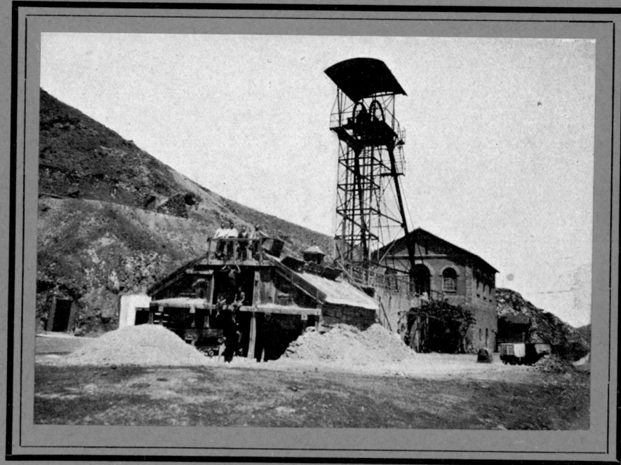
Vista del castillete, tolvas y casa-máquina de la mina «Triunfo». Al fondo izquierda, minado antiguo del filón «Rompe y Raja».
