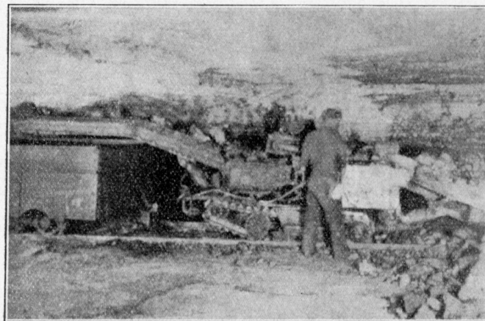
Mina Wildwood.—Cargadora mecánica para capas de poca potencia de oruga.
