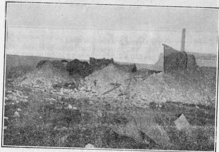
Fig. 10. — Destrucción de los últimos trozos de galería por el ensayo 287.
