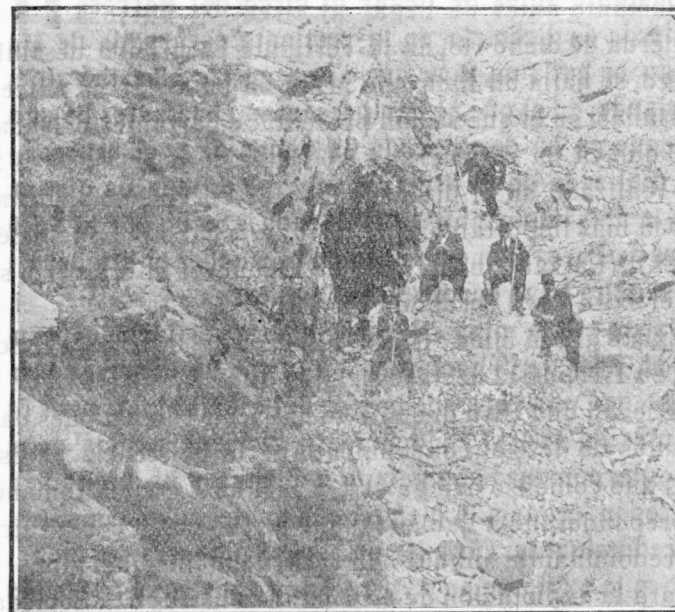
Fot. 21.—Galería de Chemenas.
