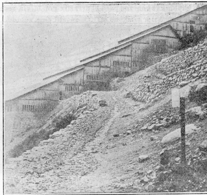
Fot. 16.—Fachada N. del lavadero.
