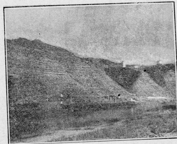
Vista de la estratificación y de las instalaciones de La Carbonífera del Ebro.—(1) Depósitos.—(2) Clasificación y cargadero.—(3) Canal de carga.—(4) Casas para obreros.—(5) Casa para el Ingeniero.
